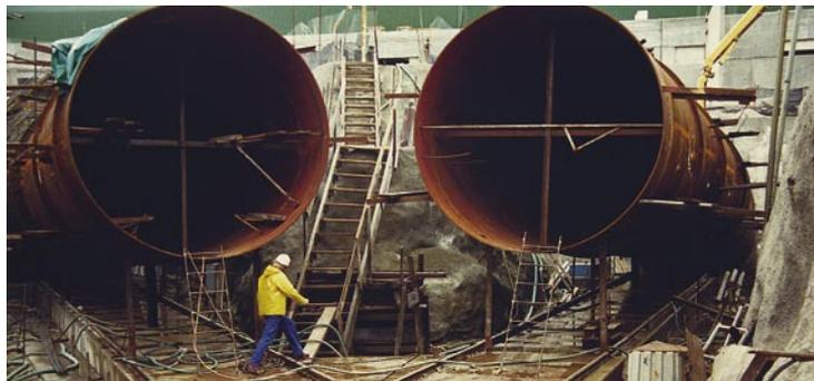
**Bild:** Verzweigung vor den Penstockshafts. Stahlrohr Ø = 3,9 m
